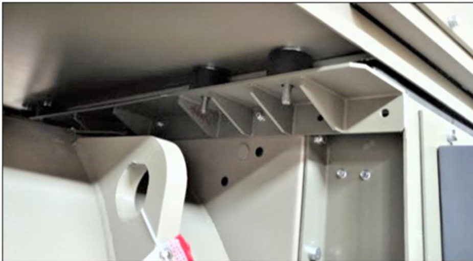
FIGURE 10. REFROIDISSEUR D'EAU ABAISSÉ EN POSITION
