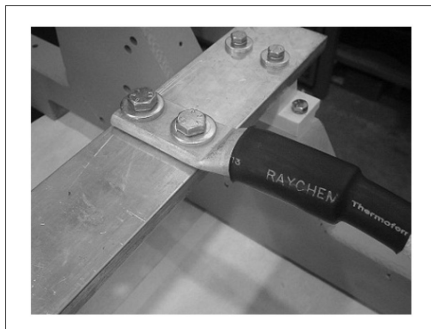
FIGUR 25. KORREKT KABELFASTSÄTTNING
