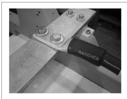
FIGURA 25. FIXAÇÃO CORRETA DO CABO COM BRAÇADEIRA
