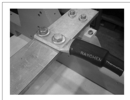
FIGURA 23. FIXAÇÃO CORRETA DO CABO COM BRAÇADEIRA
