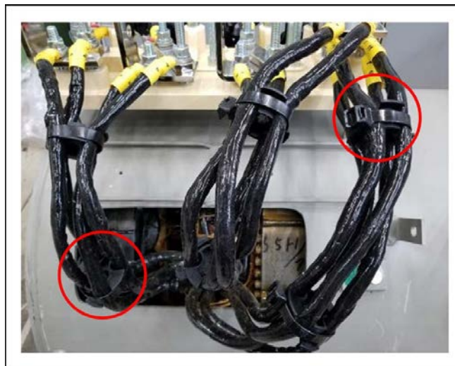
ABBILDUNG 13. LASTKABELABSTANDHALTER
