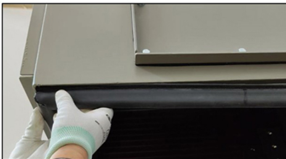
РИС. 6. УСТАНОВЛЕННАЯ ПРОКЛАДКА
