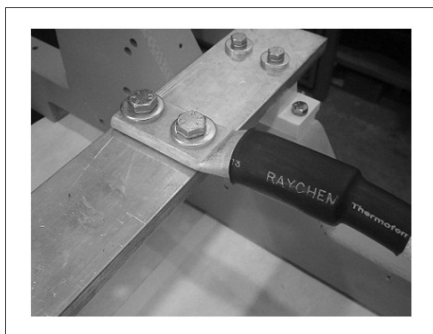
RYSUNEK 23. POPRAWNE ZACISKANIE PRZEWODÓW
