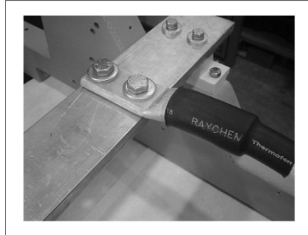
FIGUR 23. KORREKT KABELFASTSÄTTNING
