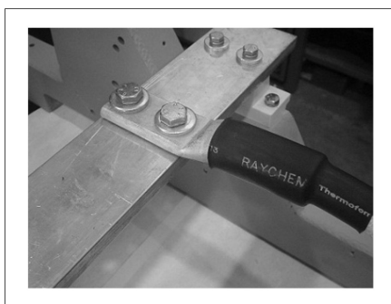
الشكل 23. التثبيت الصحيح للكابلات
