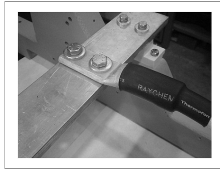
図 23. 適切なケーブル クランピング
